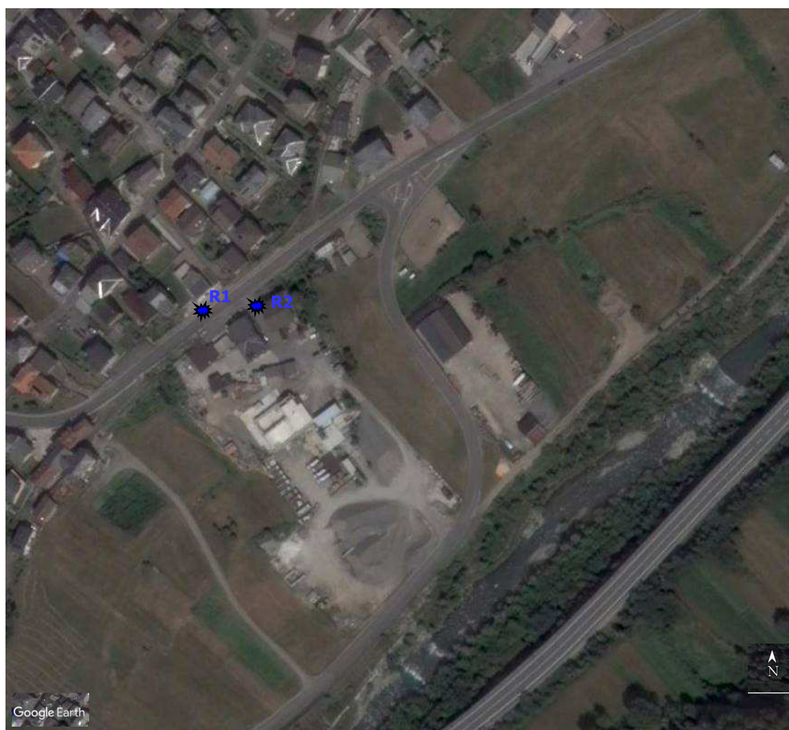
figura n. 13 - vista aerea insediamento e localizzazione punti di misura
