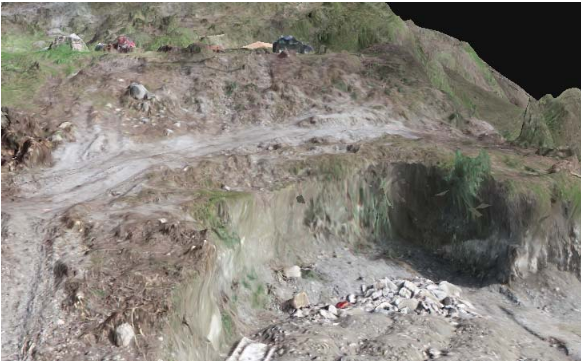
Figura 9 – Dettaglio scarpata attuale alla base del versante– FS 0,91.
