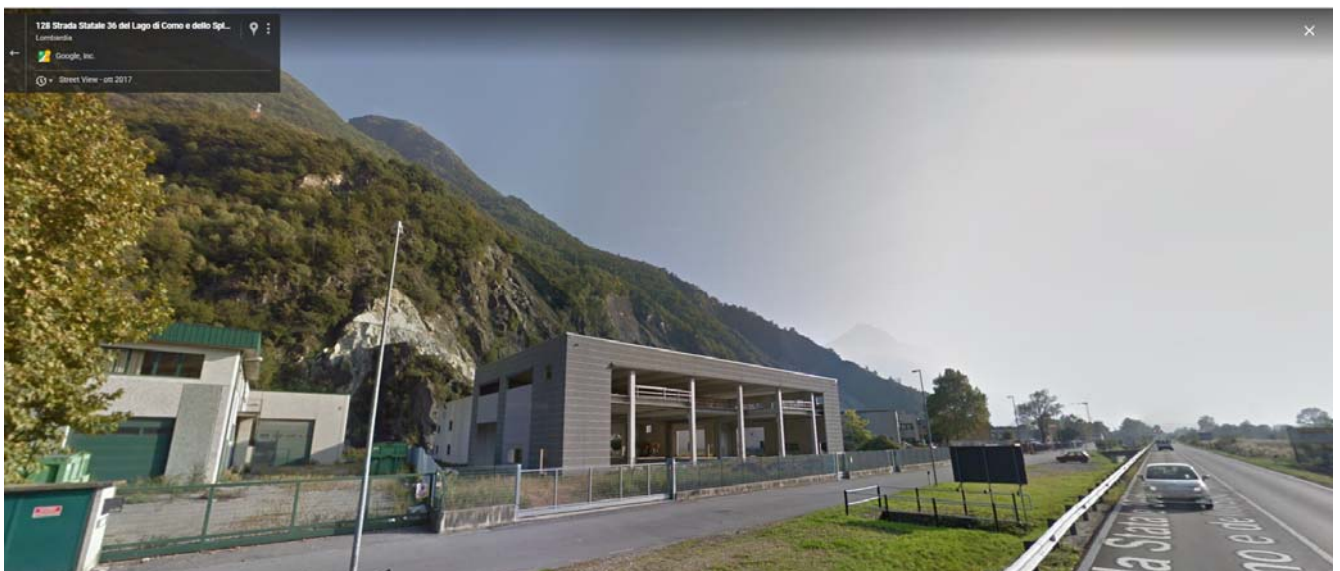
Figura 4 –Vista da nord – ovest del capannone oggetto di campagna mobile
