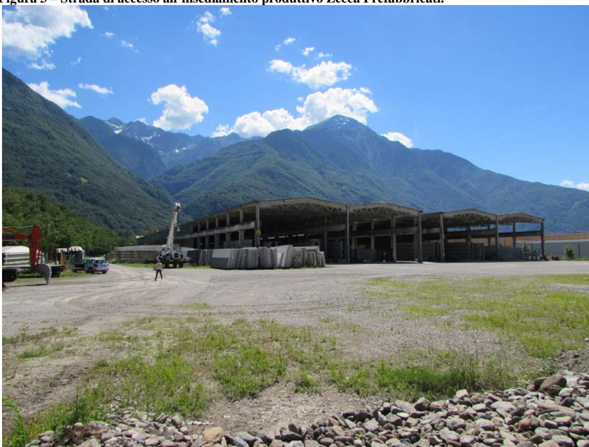
Figura 4 – Capannoni esistente del Gruppo Zecca. A sinistra del capannone l’area che sarà occupata dalla piazzola rifiuti
