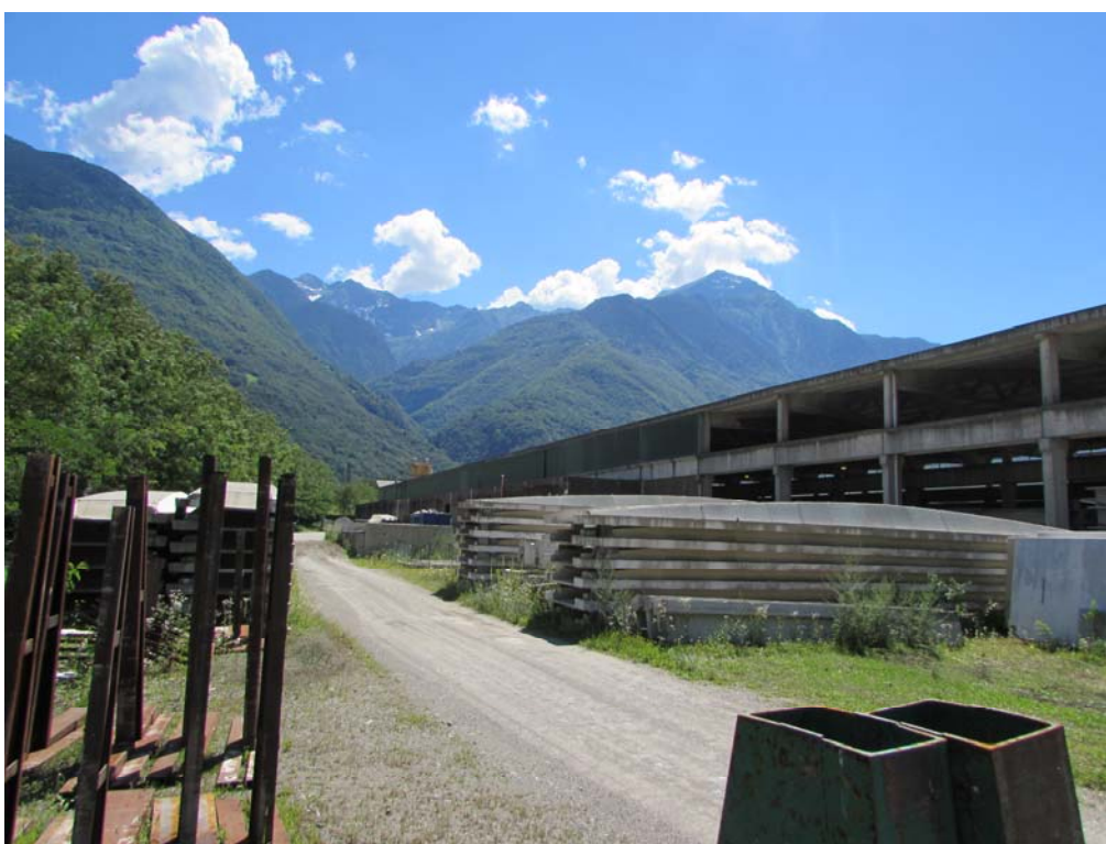
Figura 8 – Area interessata dalla futura piazzola rifiuti. Vista da nord
