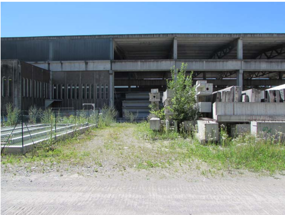
Figura 6 – Area interessata dalla futura piazzola rifiuti. Vista da est
