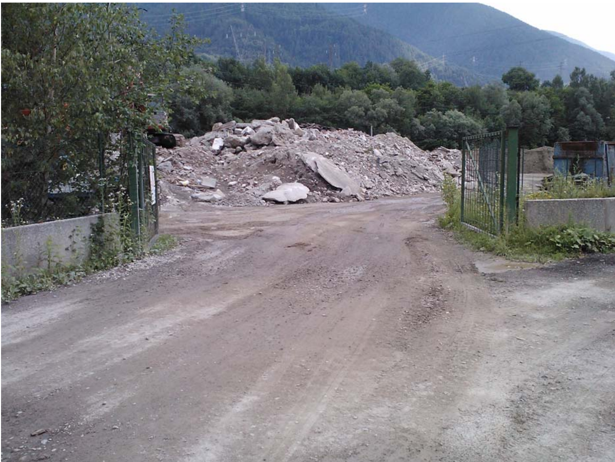
Figura 5 – Ingresso all'area di recupero rifiuti della ditta Betonvaltellina.
