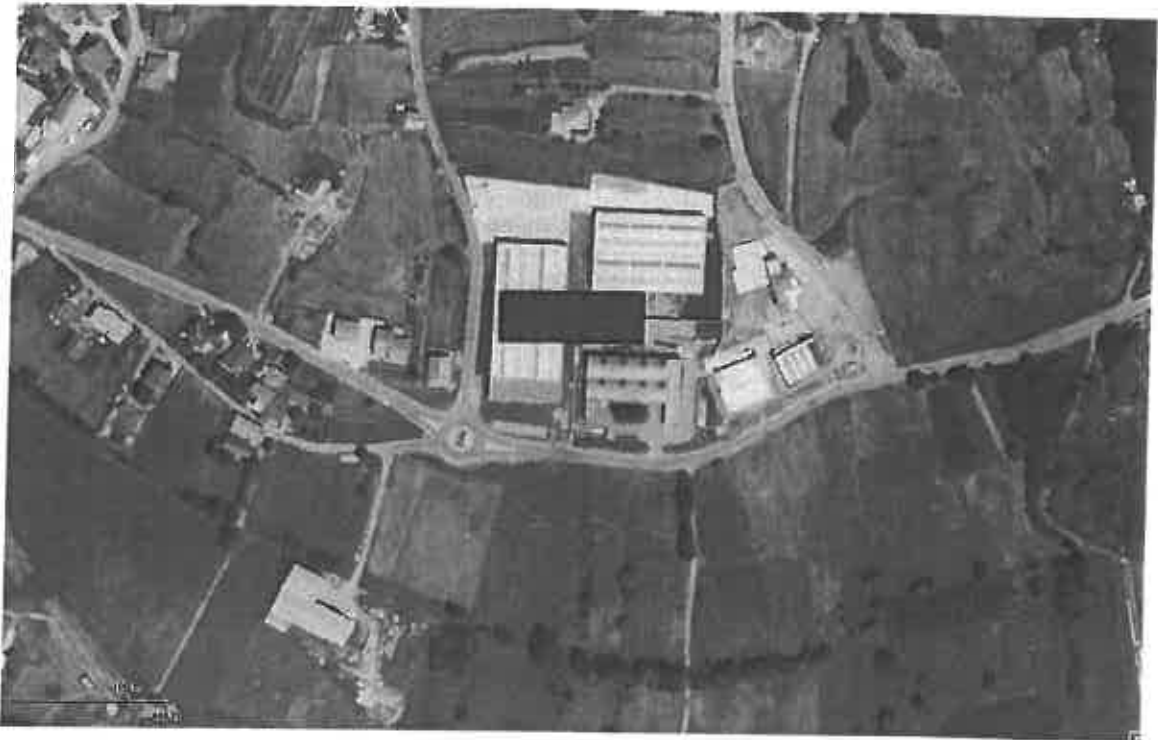
Fig. 2. Area di Buglio in Monte, via Valeriana 133.
