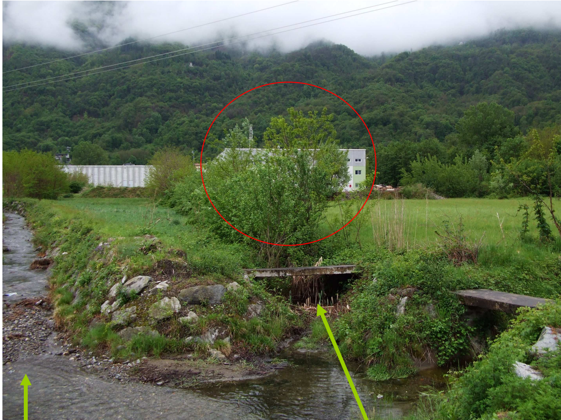
Foto n. 3: capannone ove è sito l'impianto (con il cerchio rosso e i due torrenti confinanti)
