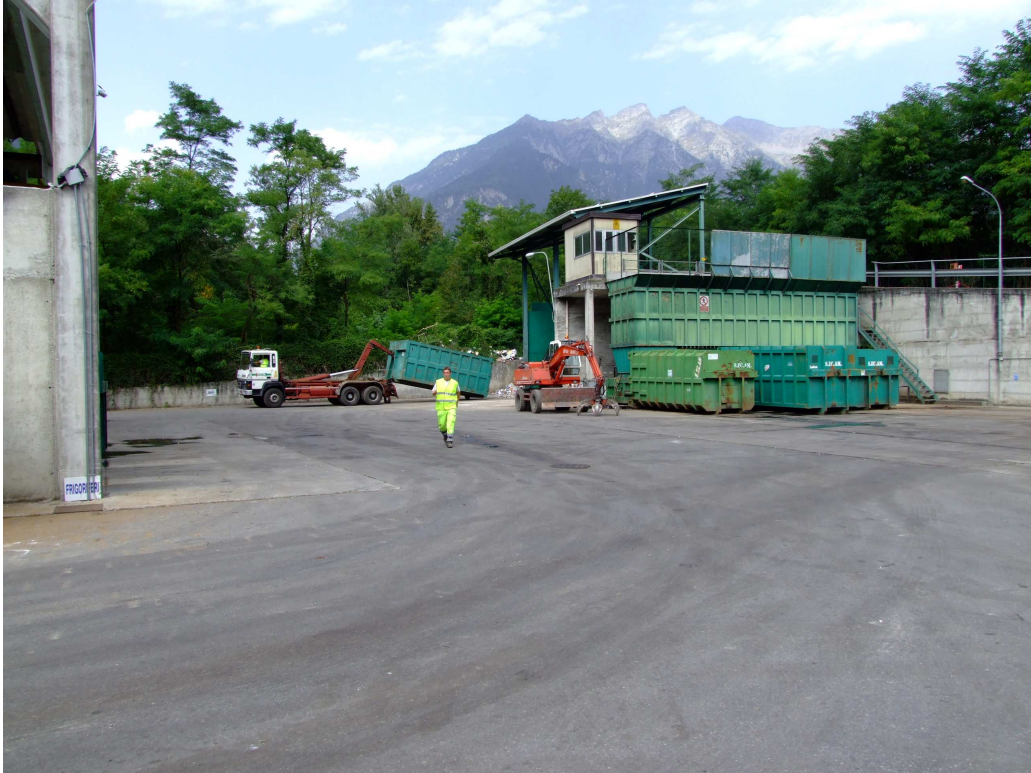
Foto n. 1: piazzale e area compattazione RSU
