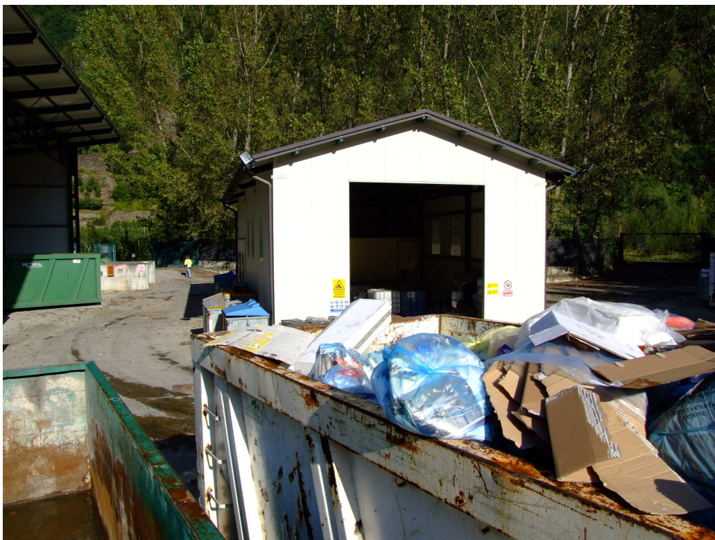
Foto 8: capannone adibito a deposito rifiuti pericolosi
