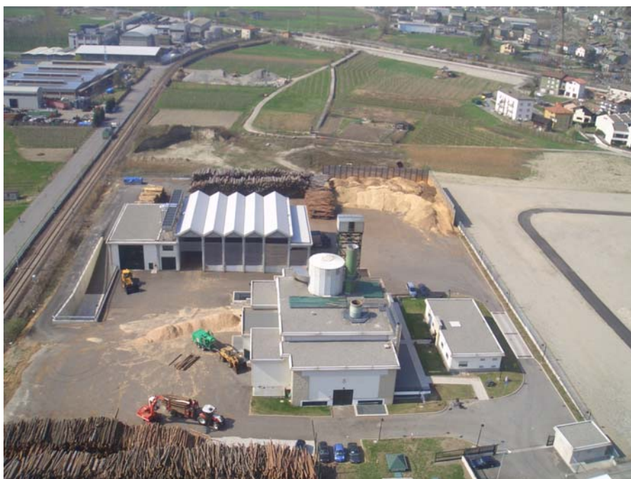
Impianto di teleriscaldamento di Tirano (fonte Soc. T.C.V.V.V. s.p.a. Tirano per g.c.)
