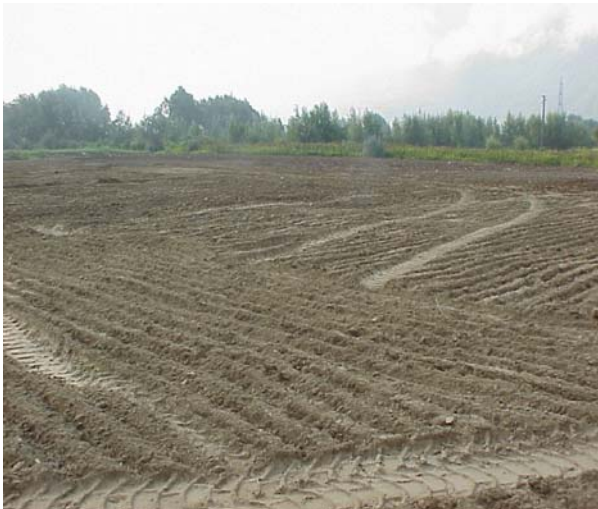
Discarica in loc. "Pedemonte" nel comune di Berbenno
