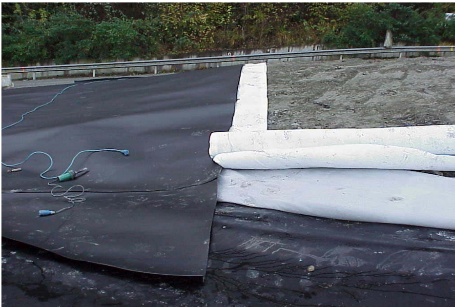
Foto 8 - Operazioni di capping finale sul 1° lotto della discarica (strato inerte, tessuto/non tessuto, telo HDPE)
