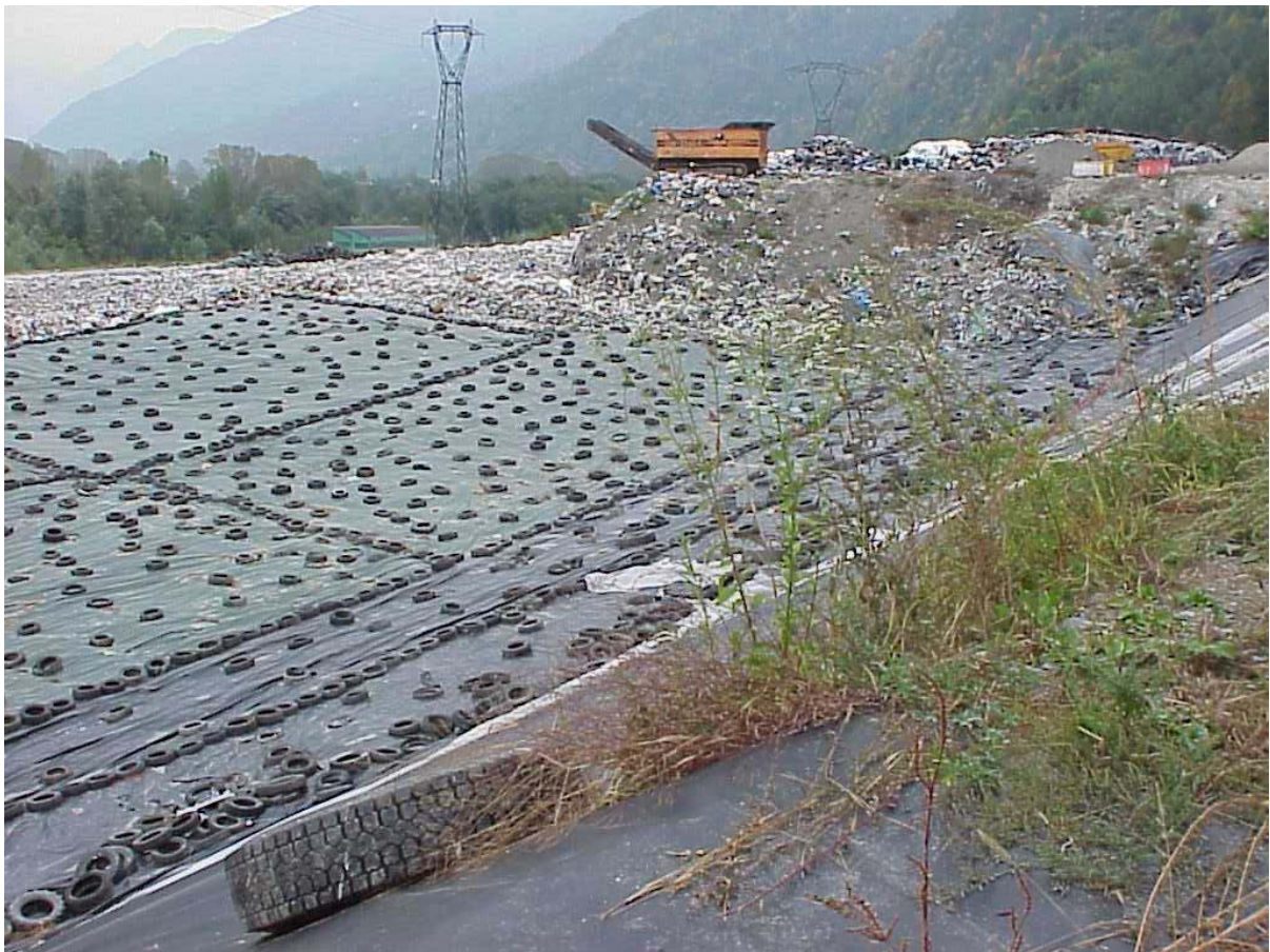
Foto 1 - Discarica controllata per r.s.u. e r.s.a.u. sita in località "Saleggio" in comune di Teglio (ottobre 2002)
