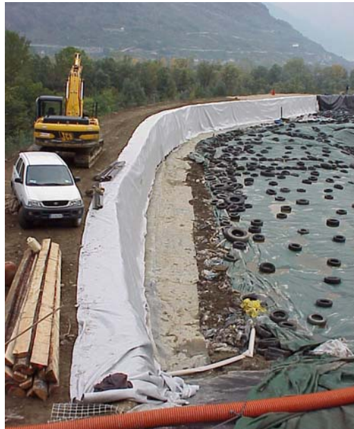
Foto 4 - Argini frontali in terra armata
