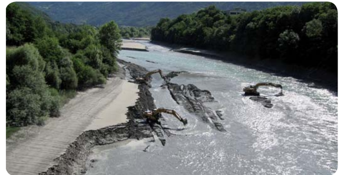
Sotto: Attività di rimozione dei depositi
