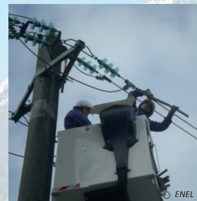
2010: Avvio del progetto Operatori ENEL al lavoro ad Ardenno per la messa in sicurezza di alcuni tralicci
