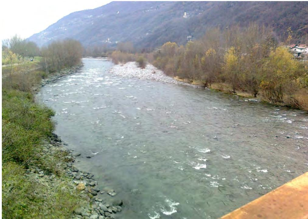
Foto 12 : Il tratto immediatamente a valle della passerella di Paniga con le evidenti arginature verso la piana di Talamona in sinistra e sulla destra quella a protezione dell'abitato di Paniga
