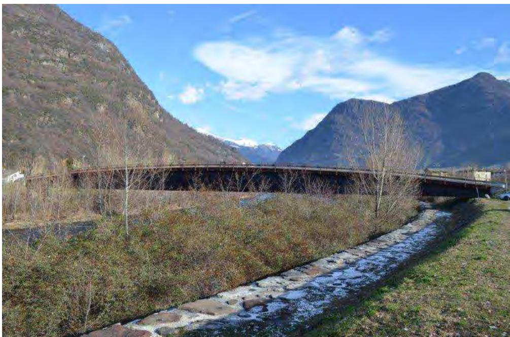
Foto 16 : Il ponte di Paniga visto da valle. Sono ben evidenti le scogliere eseguite dopo l'alluvione del 1987
