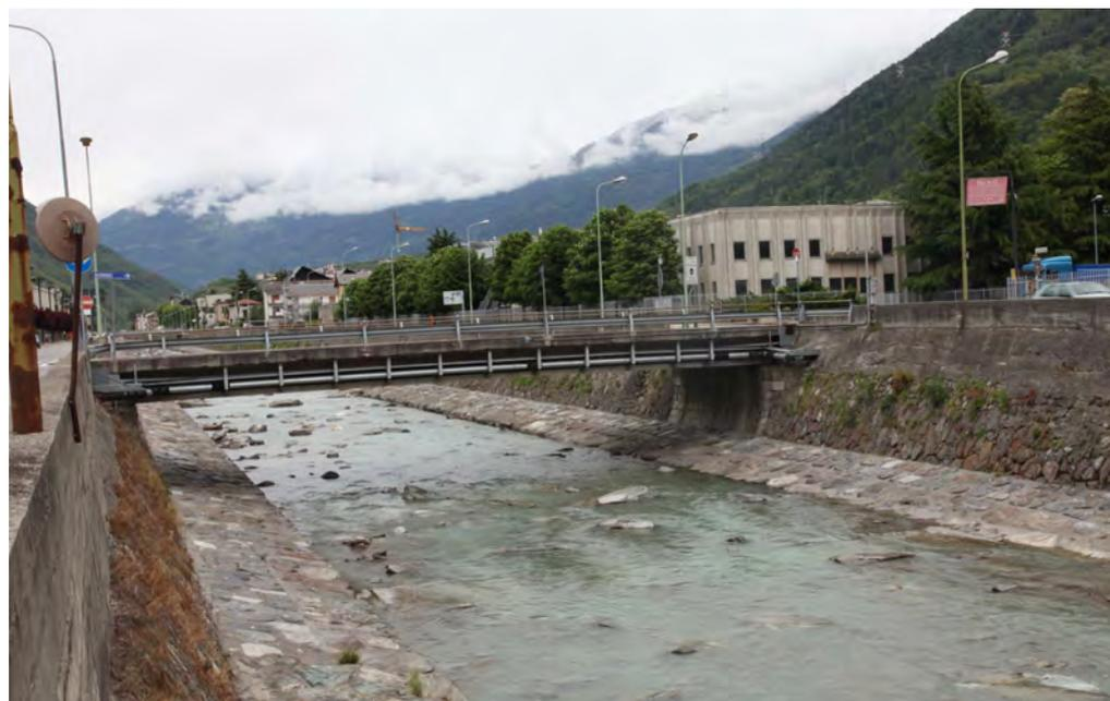
Foto 51 : Il ponte di via del commercio, con il suo intradosso evidentemente basso.
