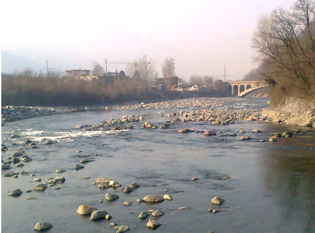
Foto 13 : Il tratto in corrispondenza dello sbocco del T. Tartano. E' ben evidente la natura del materiale e la strozzatura causata dal ponte ferroviario.
