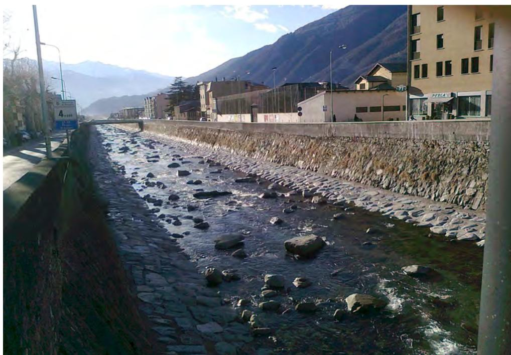
Foto 51 : Il tratto a valle del ponte della SS 38 in Tirano. E' evidente l'intervento di consolidamento degli argini e del fondo.
