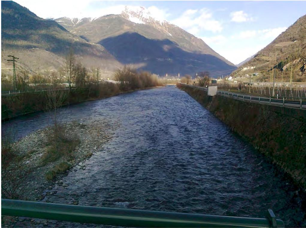
Foto 49 : Il tratto a monte del ponte di Stazzona. L'alveo è canalizzato e presenta alcuni depositi.
