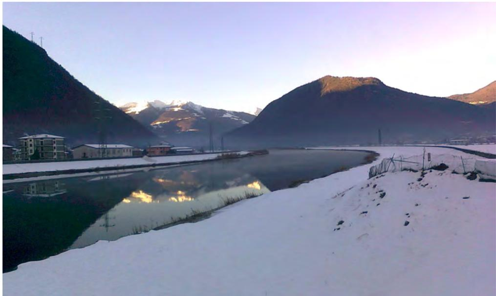
Foto 17 : Il tratto immediatamente a monte dello sbarramento di Ardenno. Le portate sono modeste e le quote di invaso minime per consentire lo sfruttamento idroelettrico.
