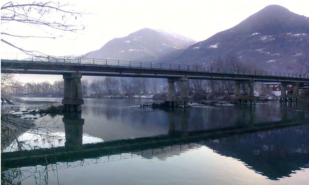
Foto 20 : Il ponte di Berbenno – Fusine con le sue pile scalzate.
