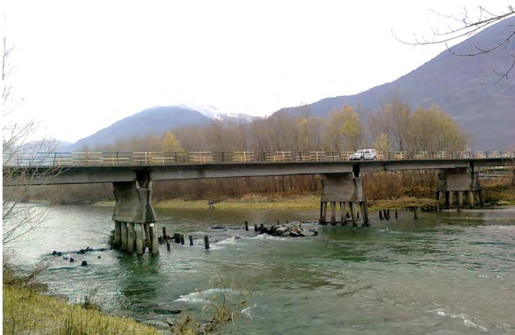
Foto 8 : Il ponte di Traona visibilmente scalzato.
