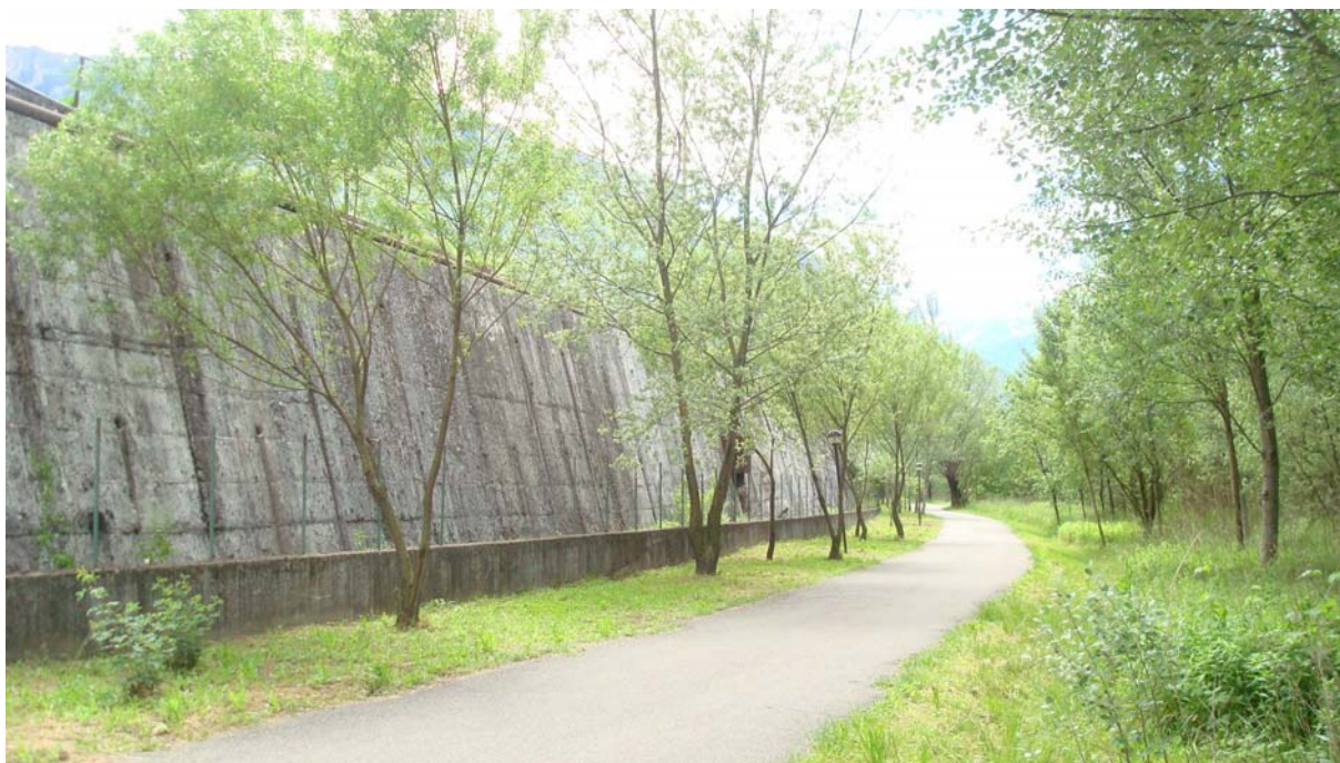
Vista sud stato di fatto
