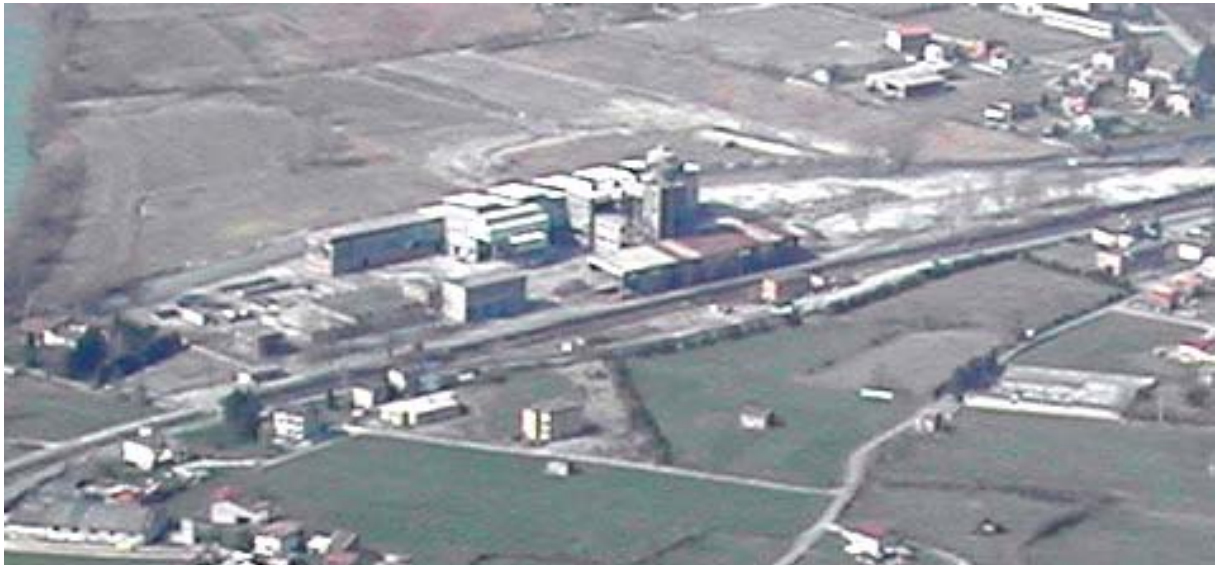
Vista area storica dell'area Falck da Sud Est .
