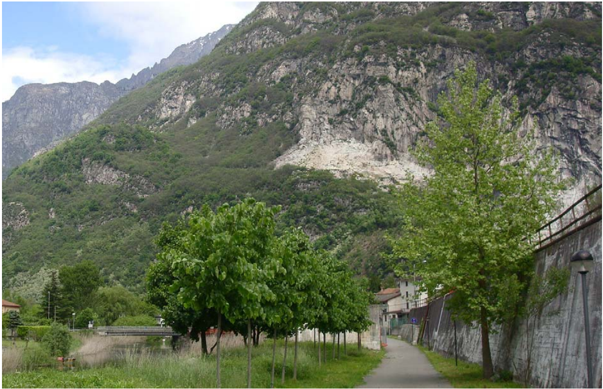
Vista nord ingresso paese stato di fatto
