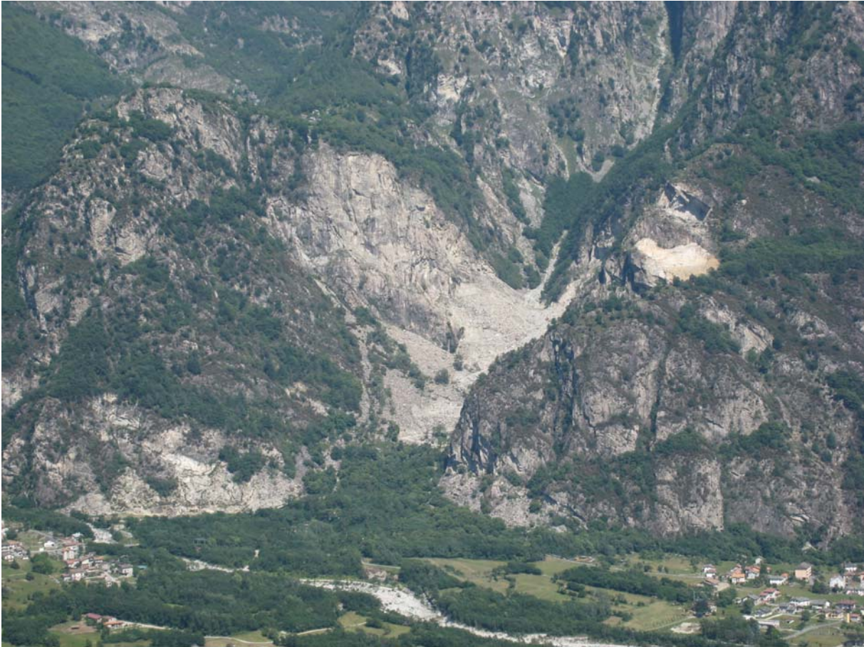
Il fondovalle della Valdimente riempito dai detriti delle discariche minerarie.
