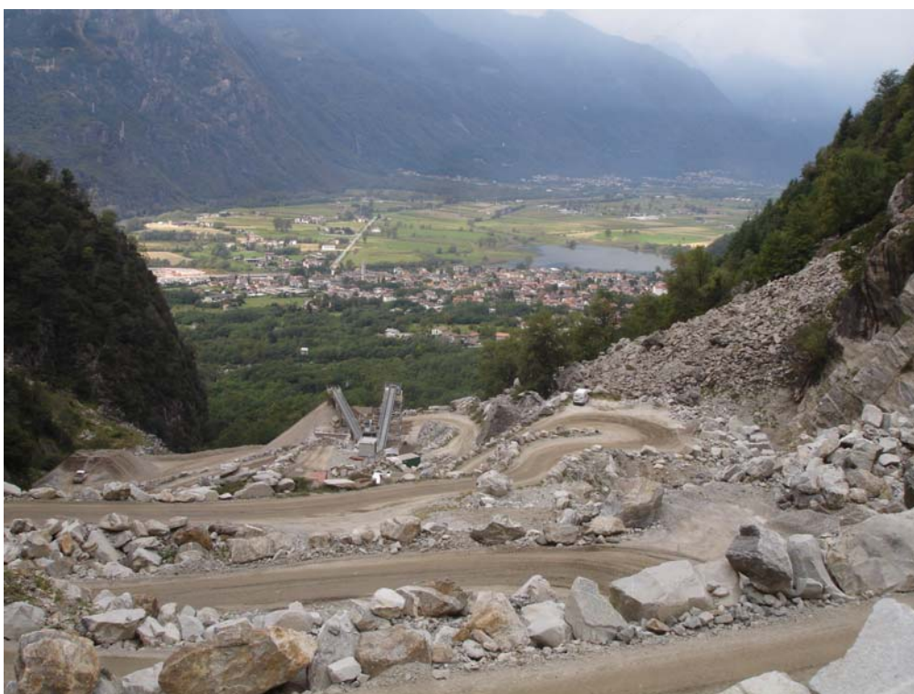
Attuale area estrattiva che si affaccia sul conoide del T.Codera
