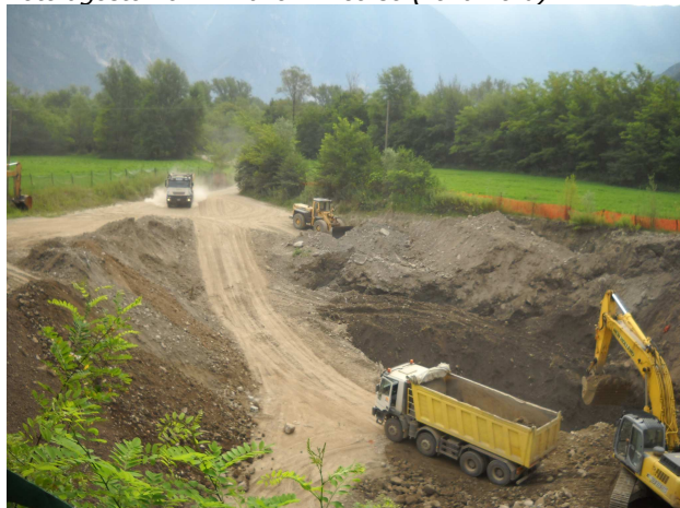
Foto agosto 2012 - Lavori in corso (zona nord)
