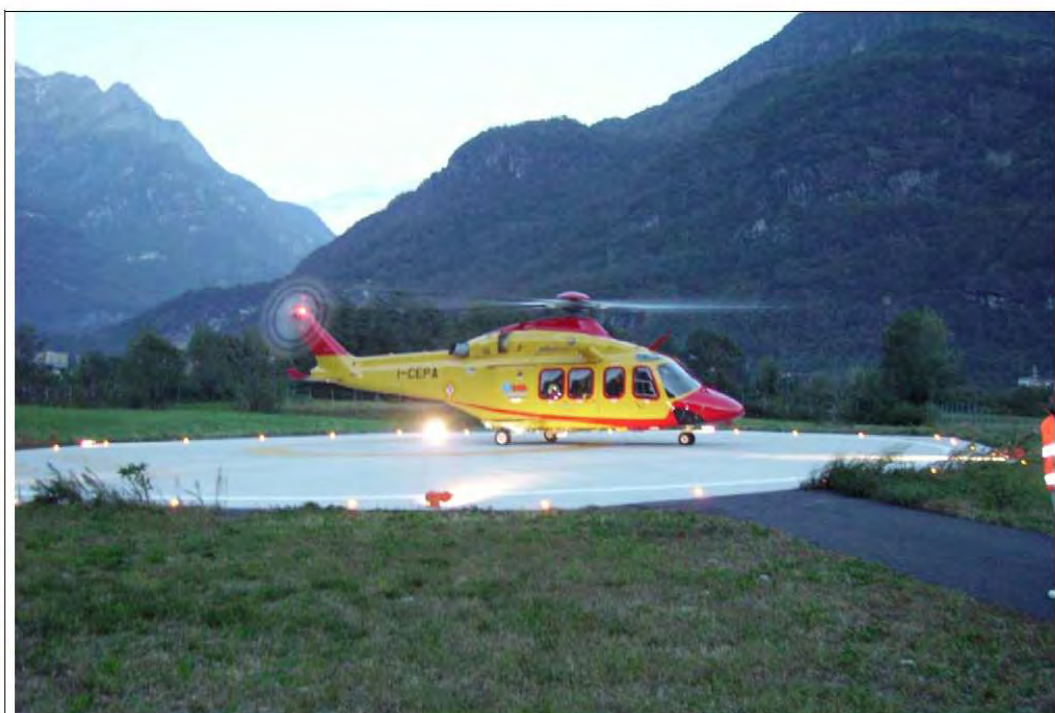
Elisuperficie di Mese - Volo notturno di prova della piazzola - ottobre 2007
